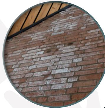
An den Innenwänden sind an den weißen Stellen die Feuchtigkeitsschäden erkennbar.
